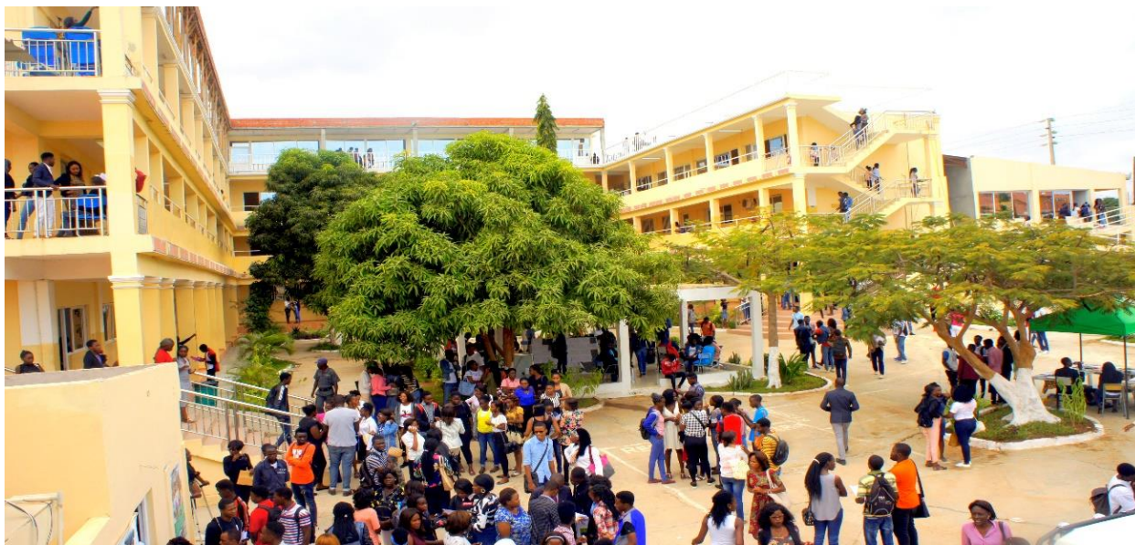
ISP-Atlântida Obra em curso com Levantamento do 3º Piso Concluído em 2020.
